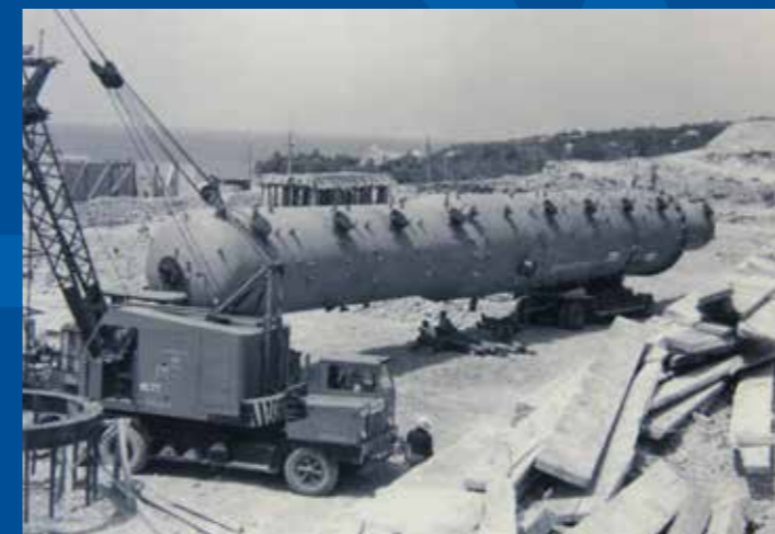
Početak izgradnje urinjske rafinerije 1963.
