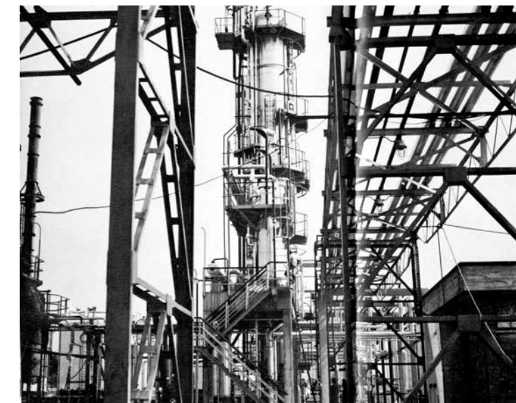
Dovršena izgradnja Maziva
